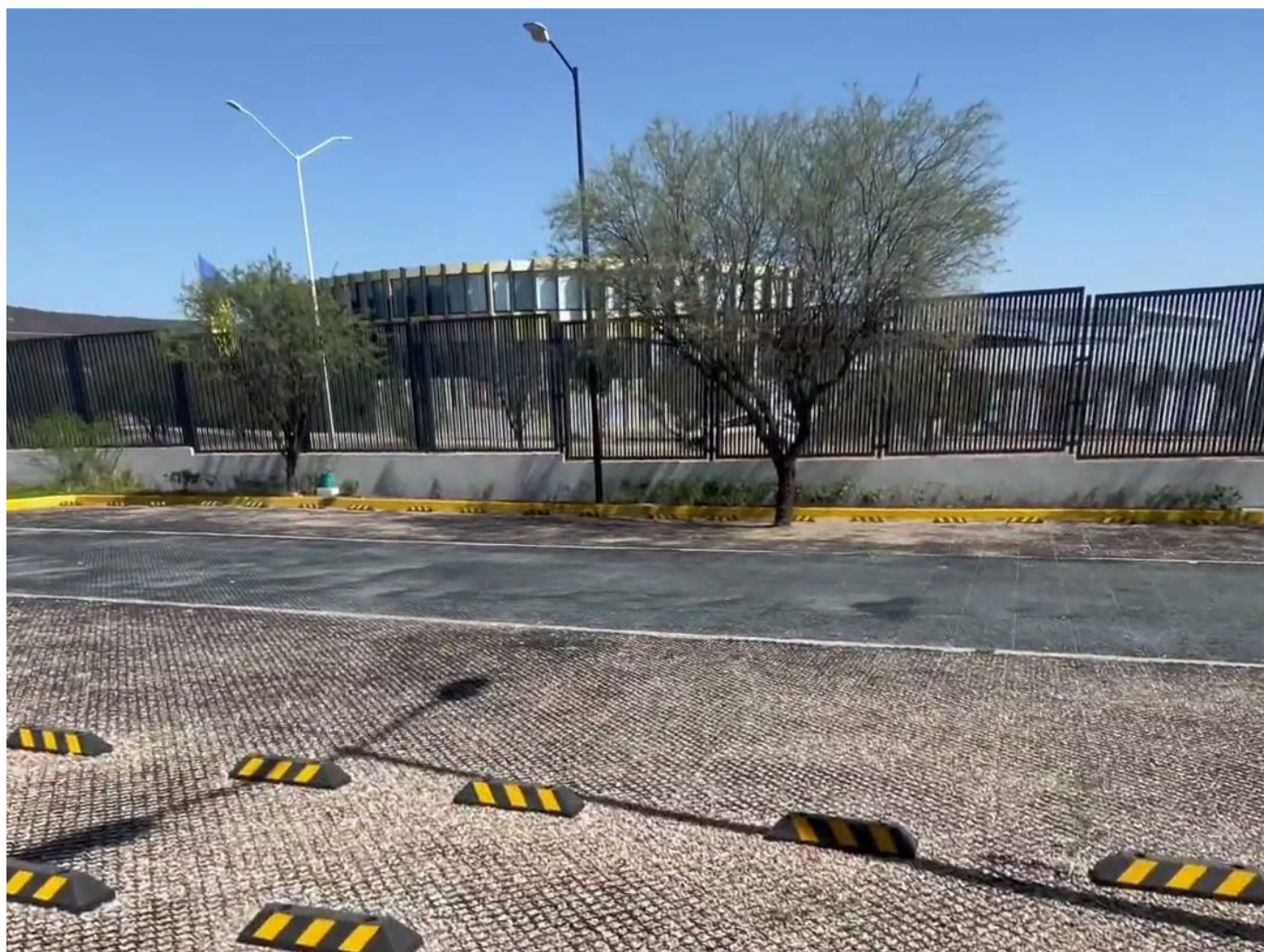
Estacionamiento terminado, en servicio
