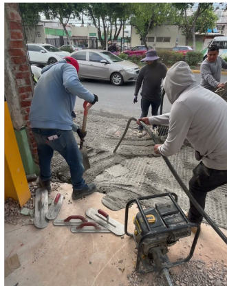
Vibrado conforme se esparce
