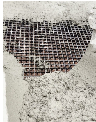
El mortero baja y llena cada celda
