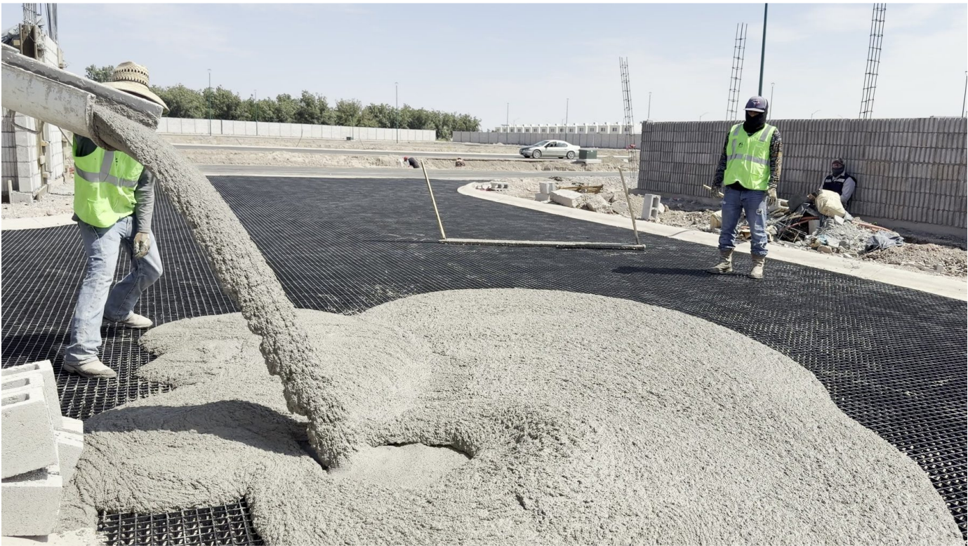
Colado con tiro directo sobre la retícula ya ensamblada.
