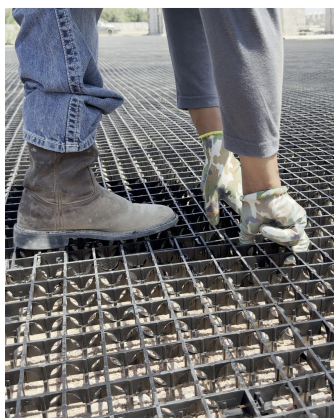
Ensamble a mano, macho con hembra
